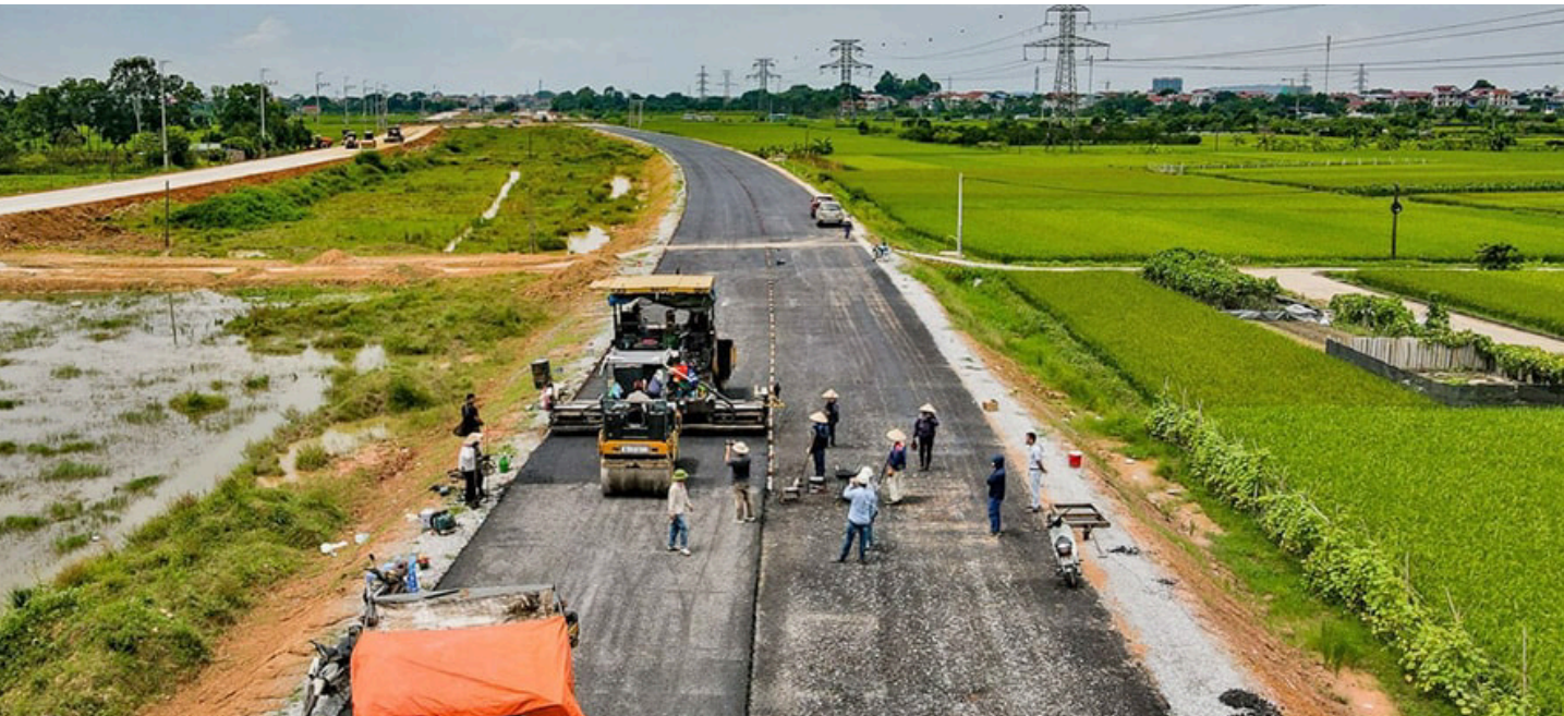
Thi công thảm nhựa đường song hành Dự án đầu tư xây dựng đường Vành đai 4 - Vùng Thủ đô Hà Nội đoạn qua huyện Sóc Sơn.
