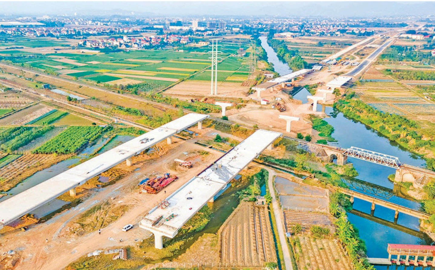
Công trường thi công Dự án đầu tư xây dựng đường Vành đai 4 - Vùng Thủ đô Hà Nội tại huyện Mê Linh.
